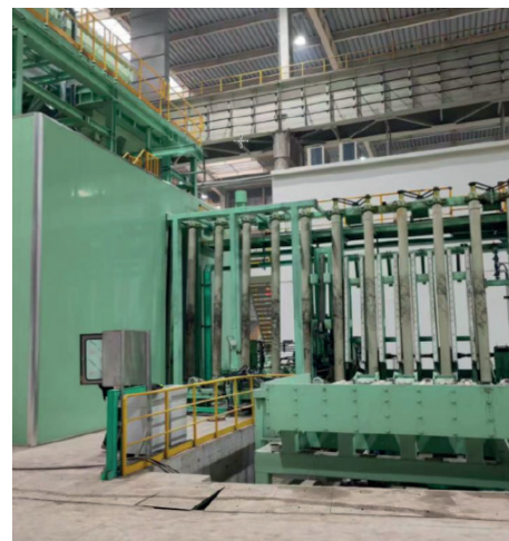
Direkt vor der Strahlanlage werden die bis zu 160 mm dicken und bis zu 4.100 mm hohen Bleche in vertikale Position gehoben und über ein Rollenbandfördersystem in die Strahlanlage transportiert. Diese durchlaufen sie mit einer Geschwindigkeit von bis zu 7 m/min.
