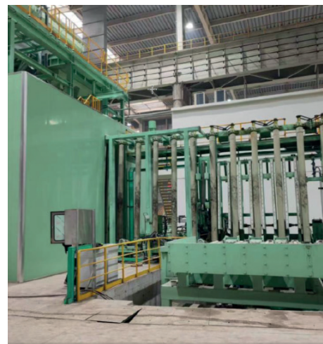
Logo em frente ao sistema de jateamento, as placas de aço inoxidável com até 160 mm de espessura e 4.100 mm de comprimento são movidas para uma posição vertical. Em seguida, elas passam pelo sistema de jateamento e pela linha de decapagem em transportadores de rolos especiais a uma velocidade máxima de 7 m/minuto.
